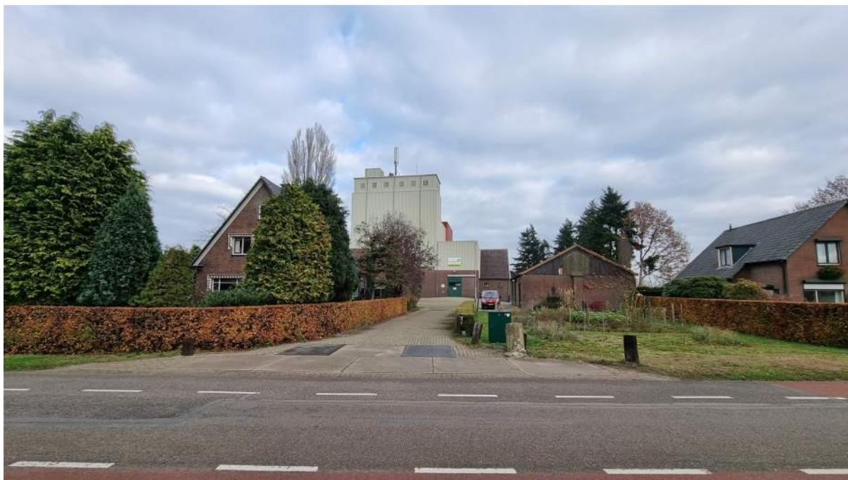
Afbeelding 3 Bestaande antenne installatie, welke komt te vervallen.
