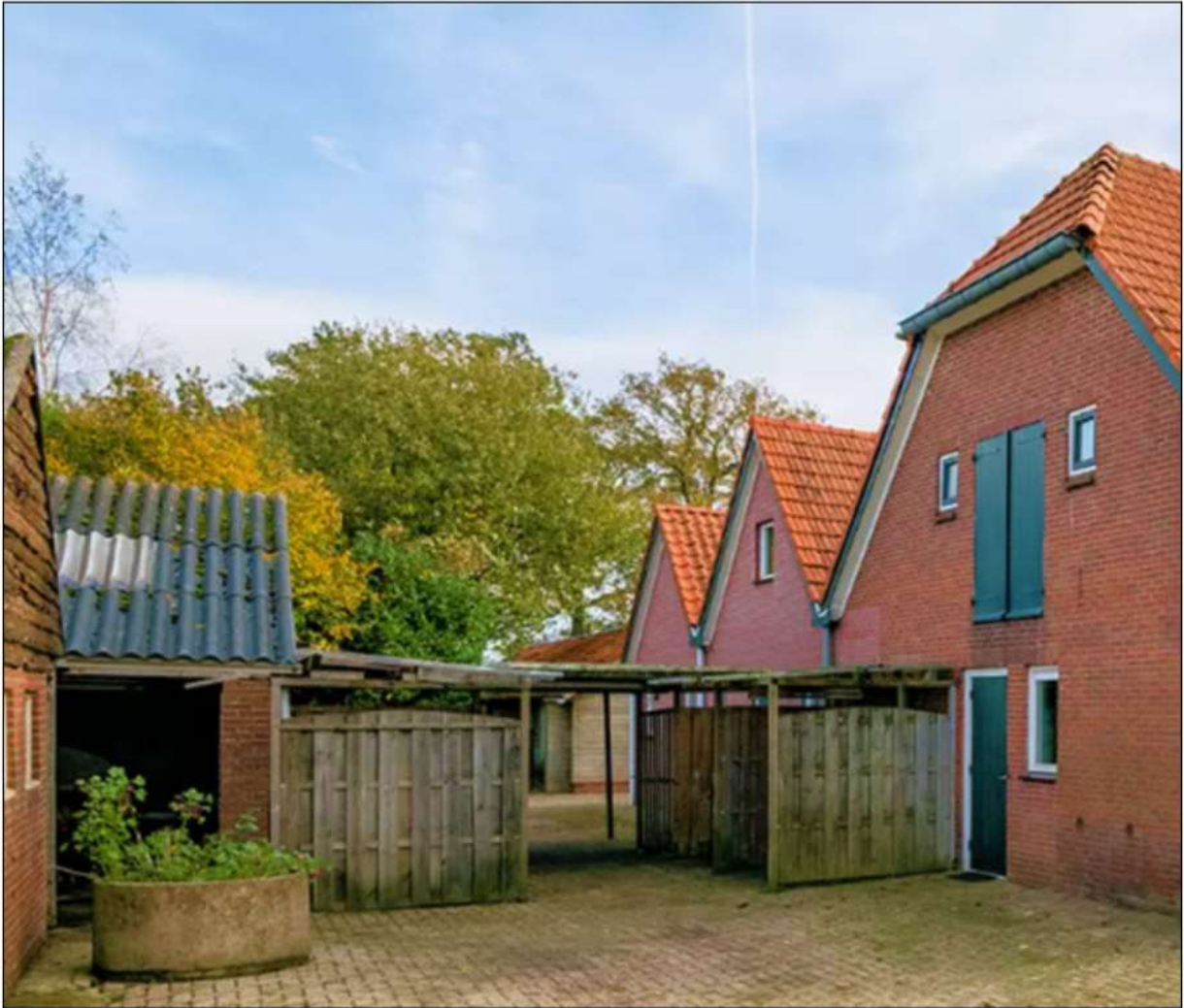
Afbeelding 9.3 Te slopen overkapping (Bron, initiatiefnemer)
